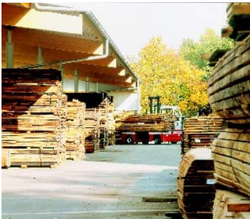
Blick ins Ende der 90er Jahre neu errichtete Schnittholzlager
